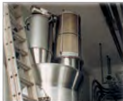
Q-Rohr® instalado en un silo de leche en polvo
