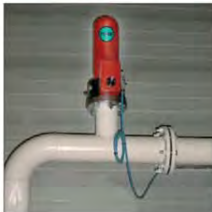
Sistema Q-Bic de REMBE® para protección de tuberías y depósitos
