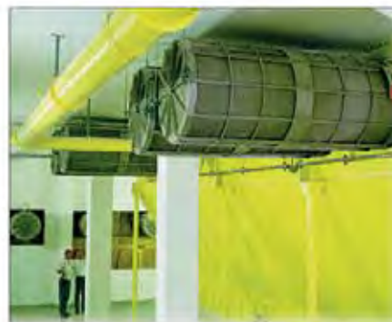
Q-Rohr® protegiendo silos de malta en cervceras
