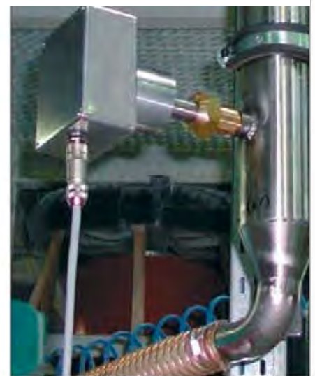
Monitorización de valores de caudal en una tubería de transporte neumático con el MicroFlow.
