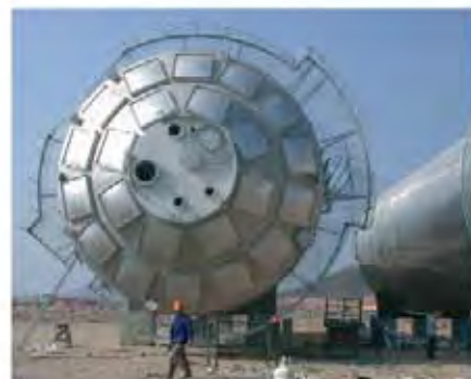
Silo con paneles de ruptura de simple capa abovedados antes de su montaje
